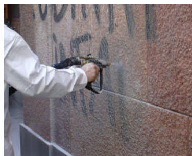
La rimozione di graffiti
